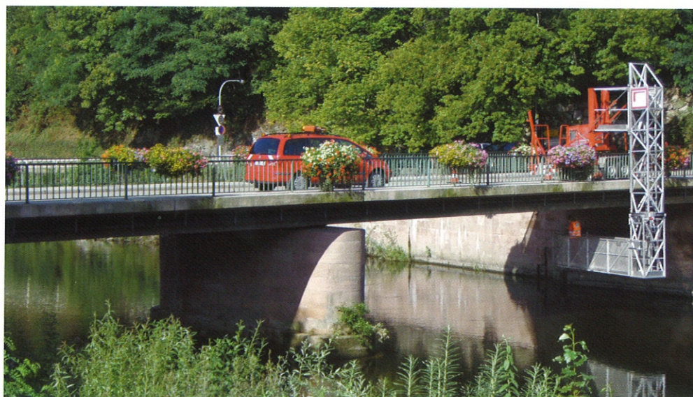
▲ Brückenprüfung mit großem Brückenuntersichtgerät
