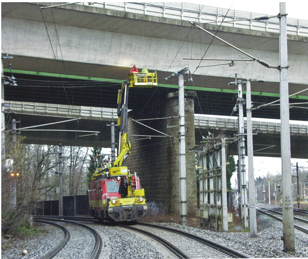
◀ Brückenprüfung im Bahnbereich
