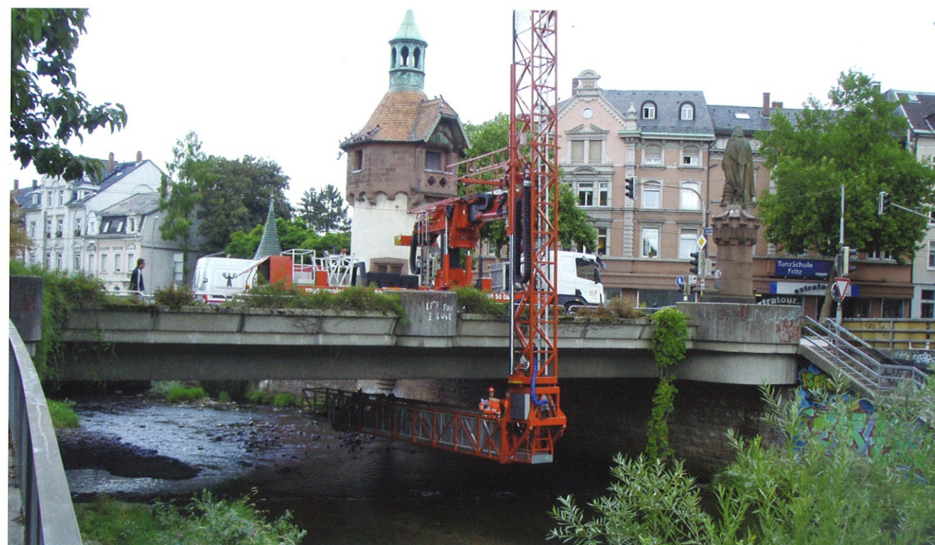
▲ Brückenprüfung mit großem Brückenuntersichtgerät
