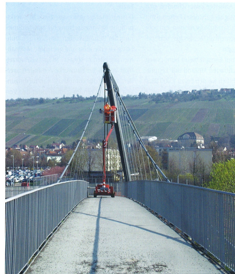
▲ Prüfung des Pylons einer Fußgängerbrücke
