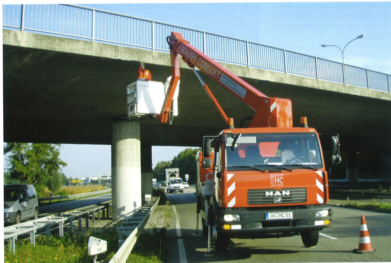
▲ Brückenprüfung mit Lkw-Hubarbeitsbühne
